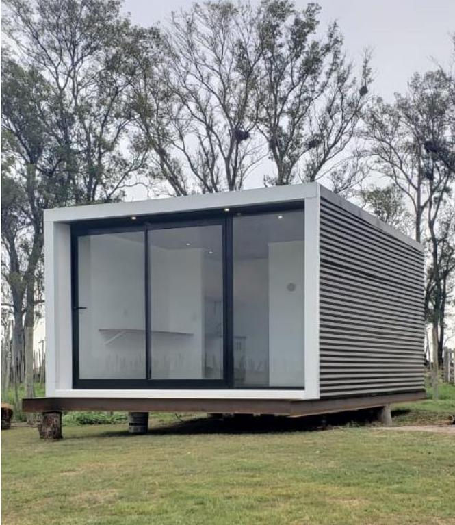
Modul.Art es un sistema de construcción en módulos, sustentable e industrializado. Éstos son de rápido montaje, transportables a cualquier destino, y además, tienen la posibilidad de ser reubicados.
